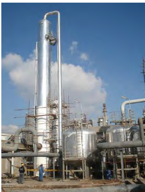
عملیات نصب و راه اندازی واحد جداسازی هوا (ASU) - پتروشیمی مارون
