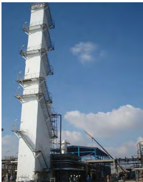
عملیات نصب و راه اندازی واحد جداسازی هوا (ASU) - پتروشیمی مارون
